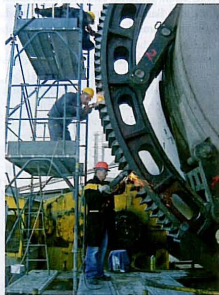
Serviceleistung im Rahmen von KlüberRepair: die mechanische Bearbeitung von Zahnflanken an Großantrieben
